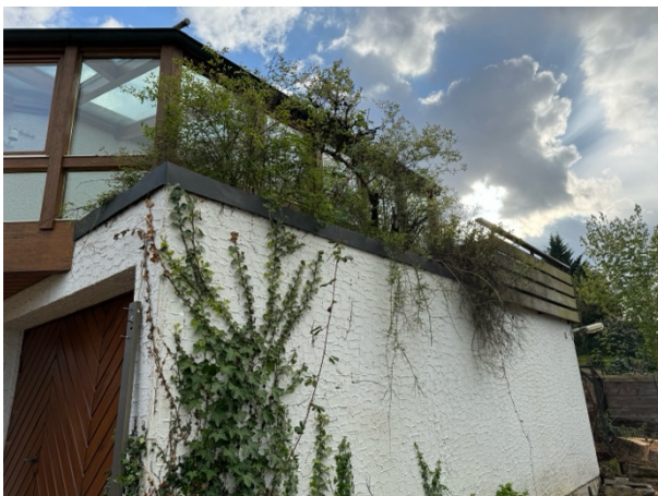
Abb. 12: Metallenes Querprofil unter dem Flachdach der nordöstlich liegenden Garage.
