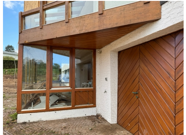
Abb. 15: Kleine Überdachung an der Nordwestseite ohne Hinweise auf eine tierische Nutzung.
