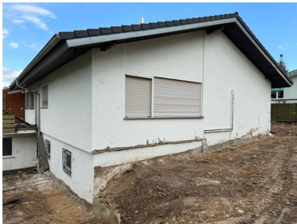
Abb. 4: Typische Außenwand der Westseite ohne Nischen oder Wandverkleidungen.
