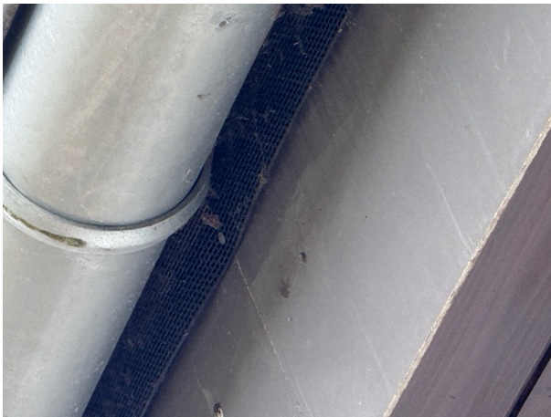
Abb. 10: Übergang zwischen Dachrinne und Wand ohne potentielles Spaltenquartier.
